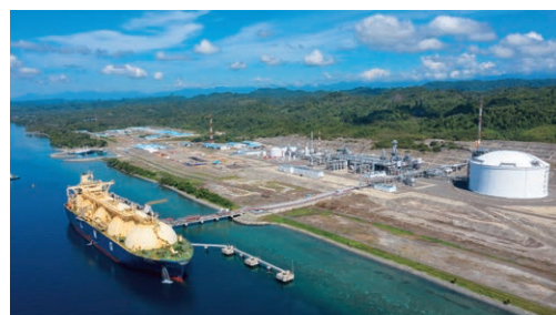
(LNG基地・バース)
